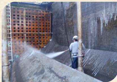
↑ 洗浄作業の様子
